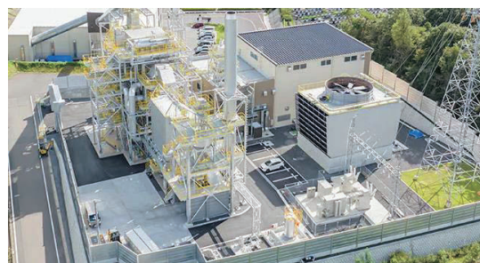
美濃加茂バイオマス発電所
