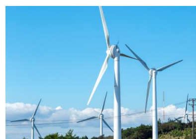
リブレース前の青山風力発電所
