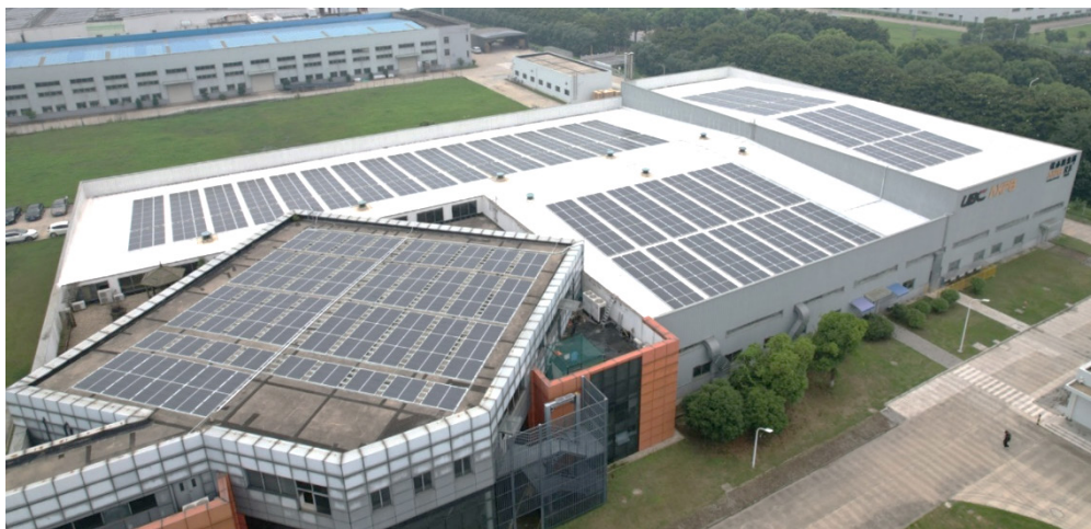
優必勝（蘇州）軸承有限公司で導入した太陽光発電システム
