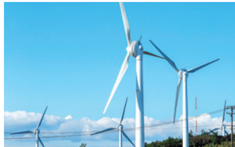
青山高原風力発電所
