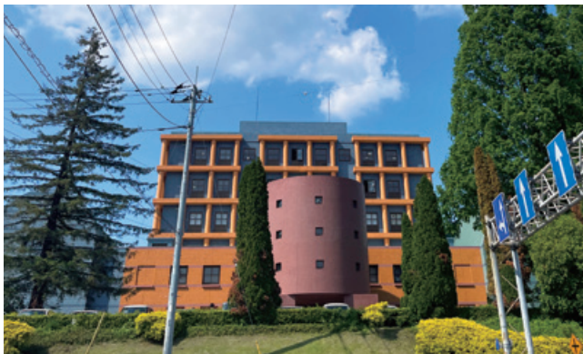
つくば営業所が入居するビル
