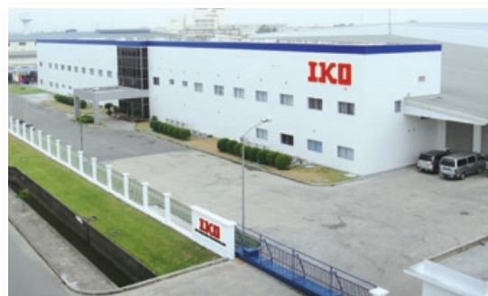
増築後の工場外観
