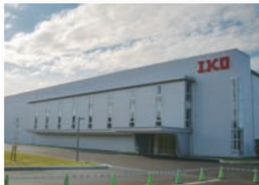
土岐工場棟の外観
