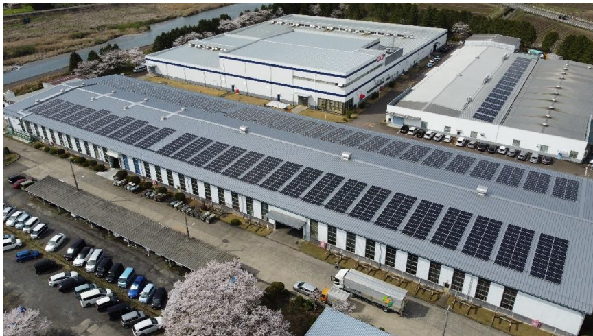
岐阜製作所（武芸川地区）で導入した太陽光発電パネル
