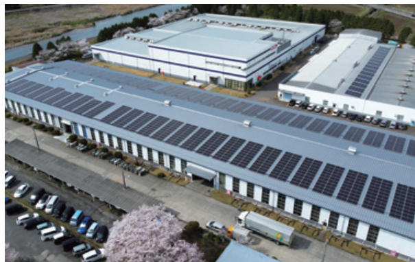
岐阜製作所（武芸川地区）で導入した太陽光発電パネル
